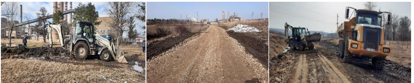
Hapja e kanalit për largimin e ujit të grumbulluar të TCA-ja dhe rregullimin i rrugës hyrëse/dalëse në DPRT- Dardhishtë
