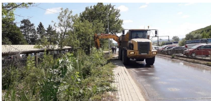
Pamje gjatë hapjes së kanalit përgjatë rrugës nga IMP deri te muri i Seperacionit A.
